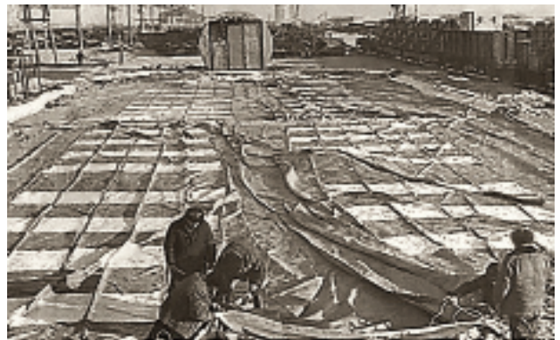
Монтаж воздухоопорного склада на Запорожской ГРЭС
