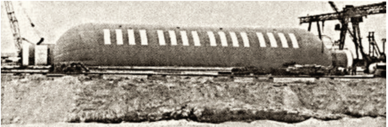
Запорожская ГРЭС. Вид воздухоопорного склада
