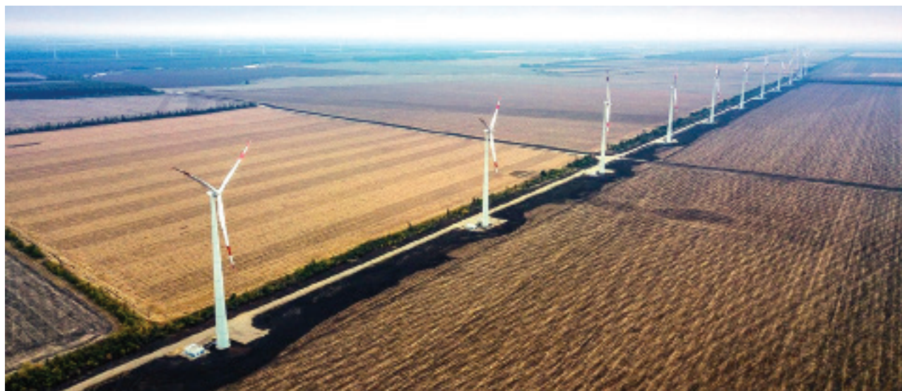
Адыгейская ВЭС мощностью 150 МВт («Росатом»)
