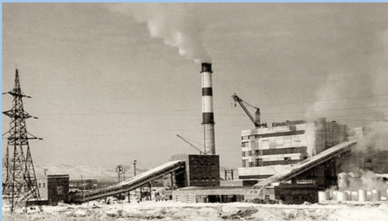
Завершение строительства и вывод на проектную мощность Сахалинской ГРЭС. 1972 г.
