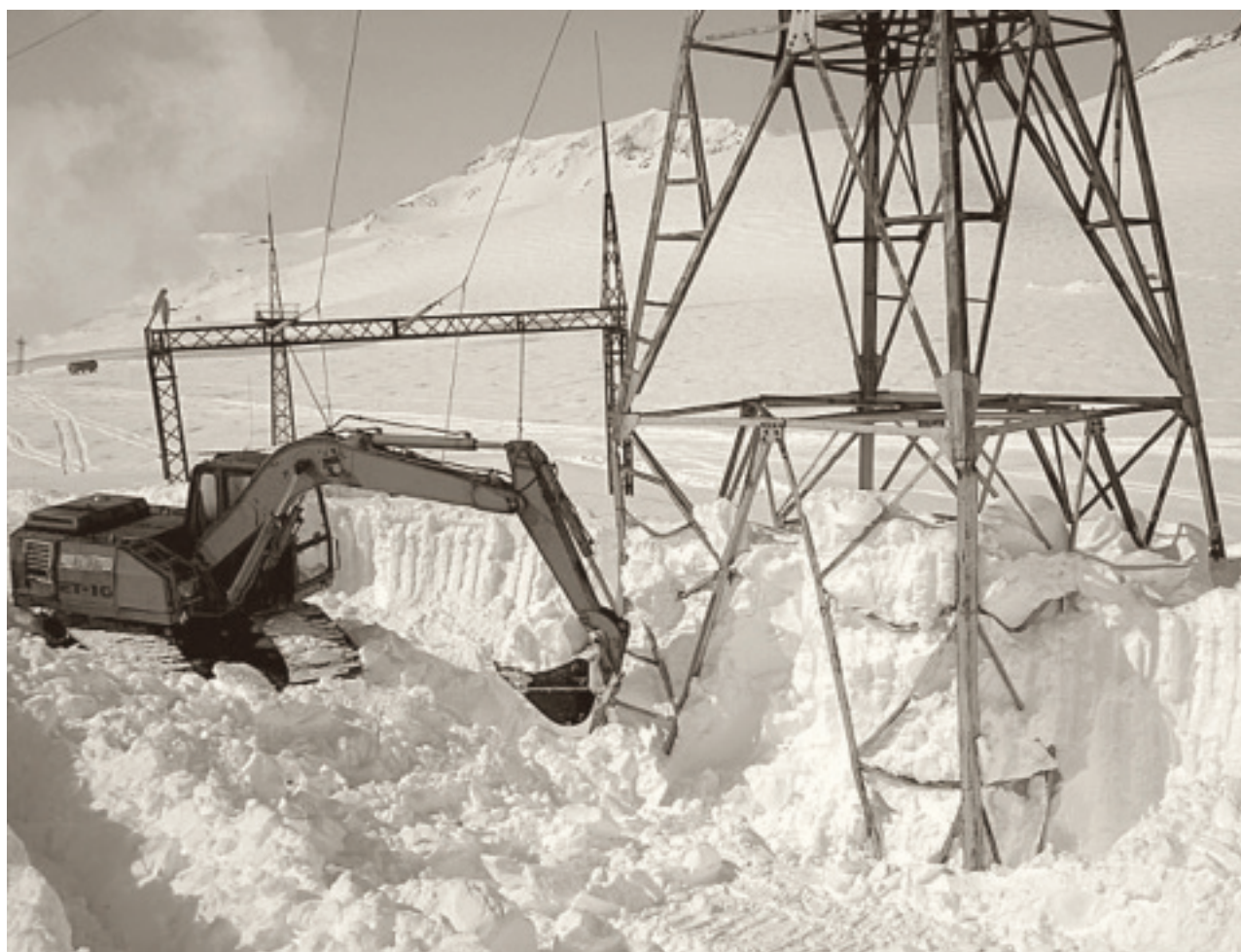
Повреждение от уплотнения снега ЛЭП-058
