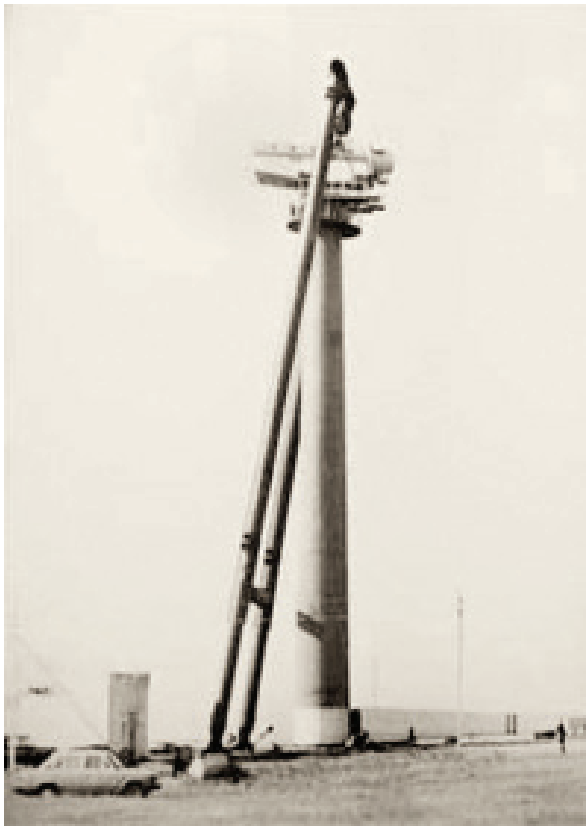
Монтаж ВЭУ Р-1000 «шевром» и готовая установка
