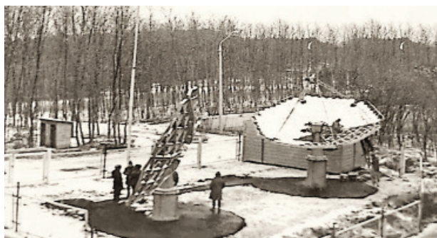
Экспериментальные солнечные установки в Кисловодске в стадии монтажа и готовности
