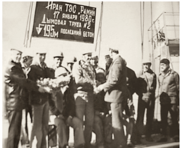
Завершение бетонирования ствола дымовой трубы № 2.
