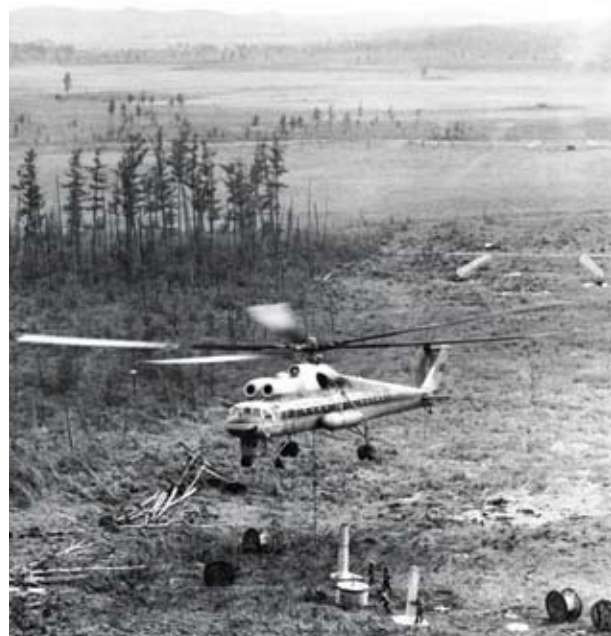
Трасса во время строительства ВЛ-500 кВ «Хабаровск – Комсомольск»
