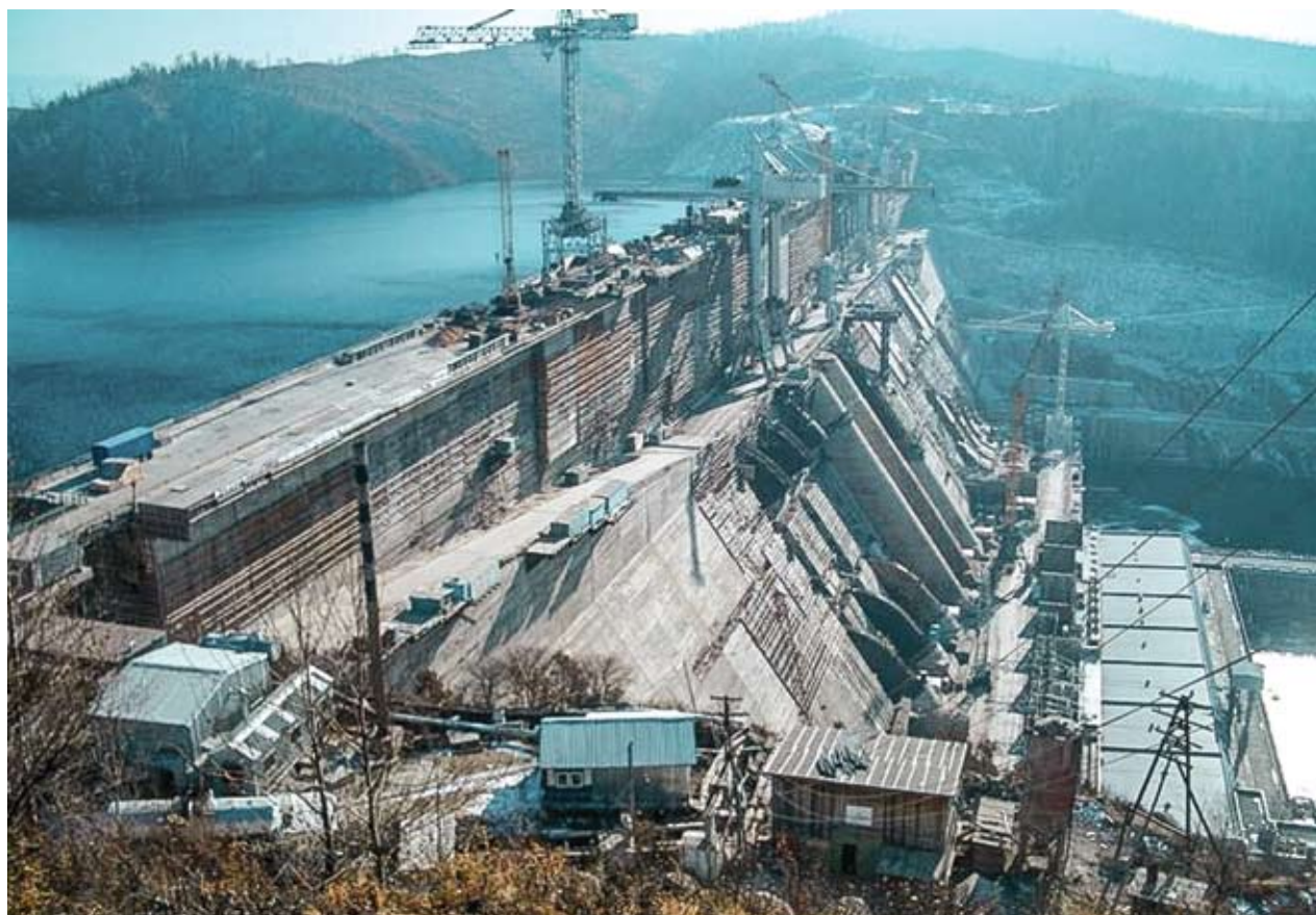
Строительство Бурейской ГЭС
