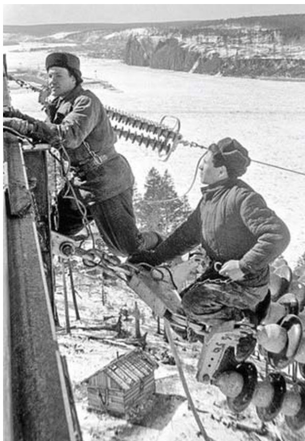
Работа электриков зимой
