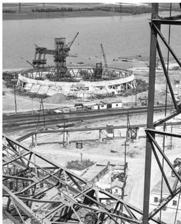
Строительство башни-охладителя на Старобешевской ГРЭС им. В.И. Ленина. 1966 год
