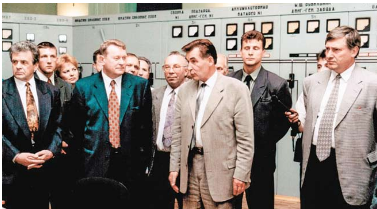
На пульте пускового блока 100 МВт Томской ГРЭС-2
