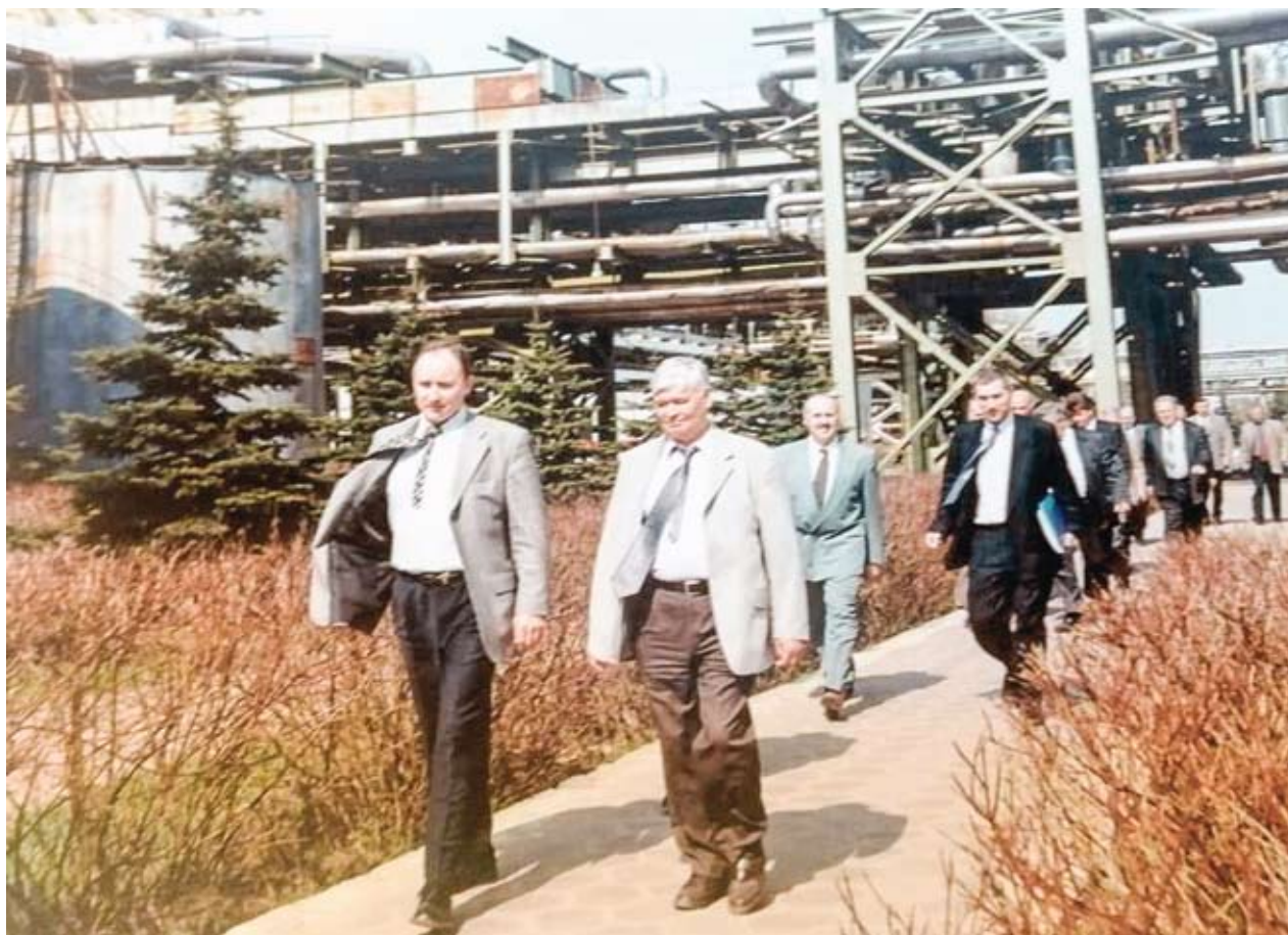
В. М. Карцев на стройке ТЭЦ-5
