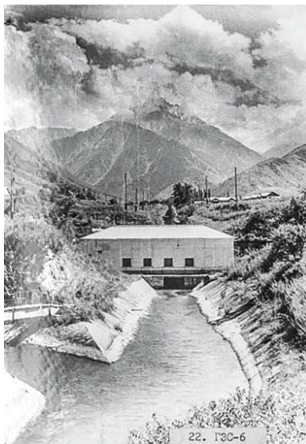
ГЭС-6 Алма-Атинской энергосистемы
