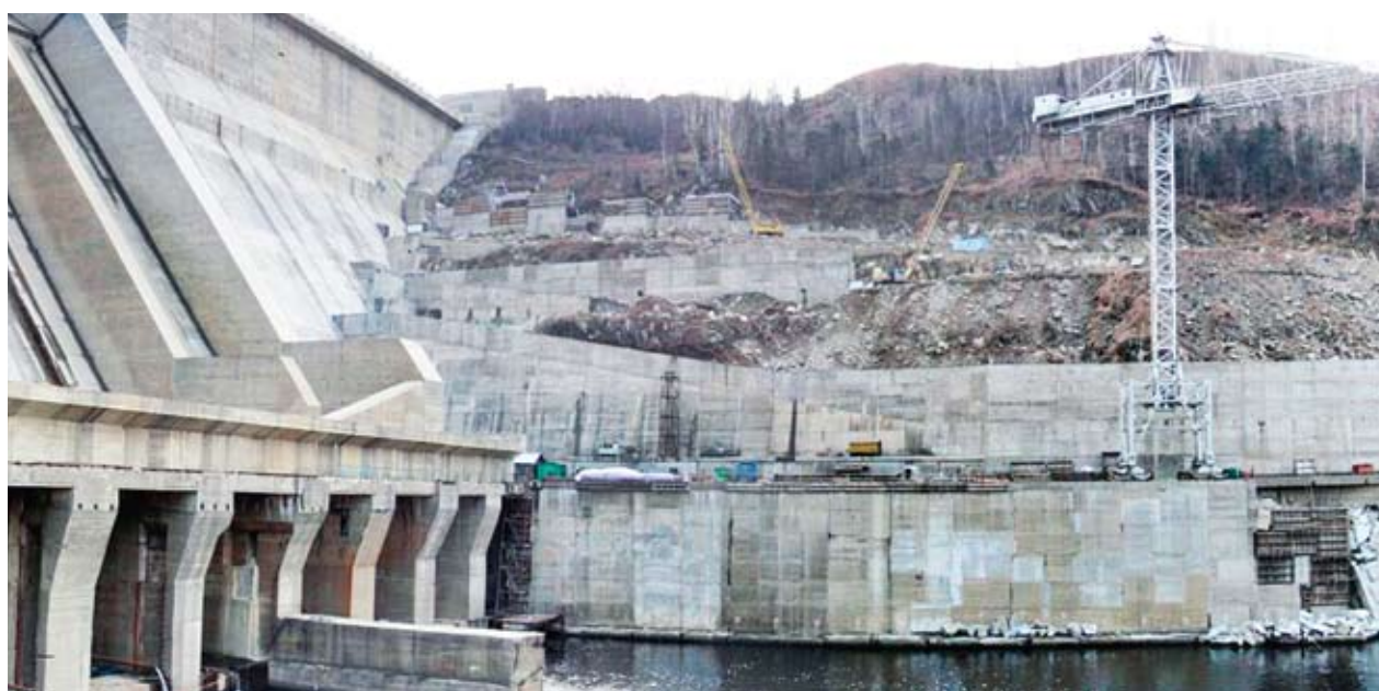
Начало строительства Бурейской ГЭС
