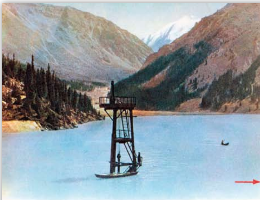
Большое Айма-Атинское озеро. В центре видна вышка водомерника; отсюда поток воды направляется к турбинам каскада гидроэлектростанций.
