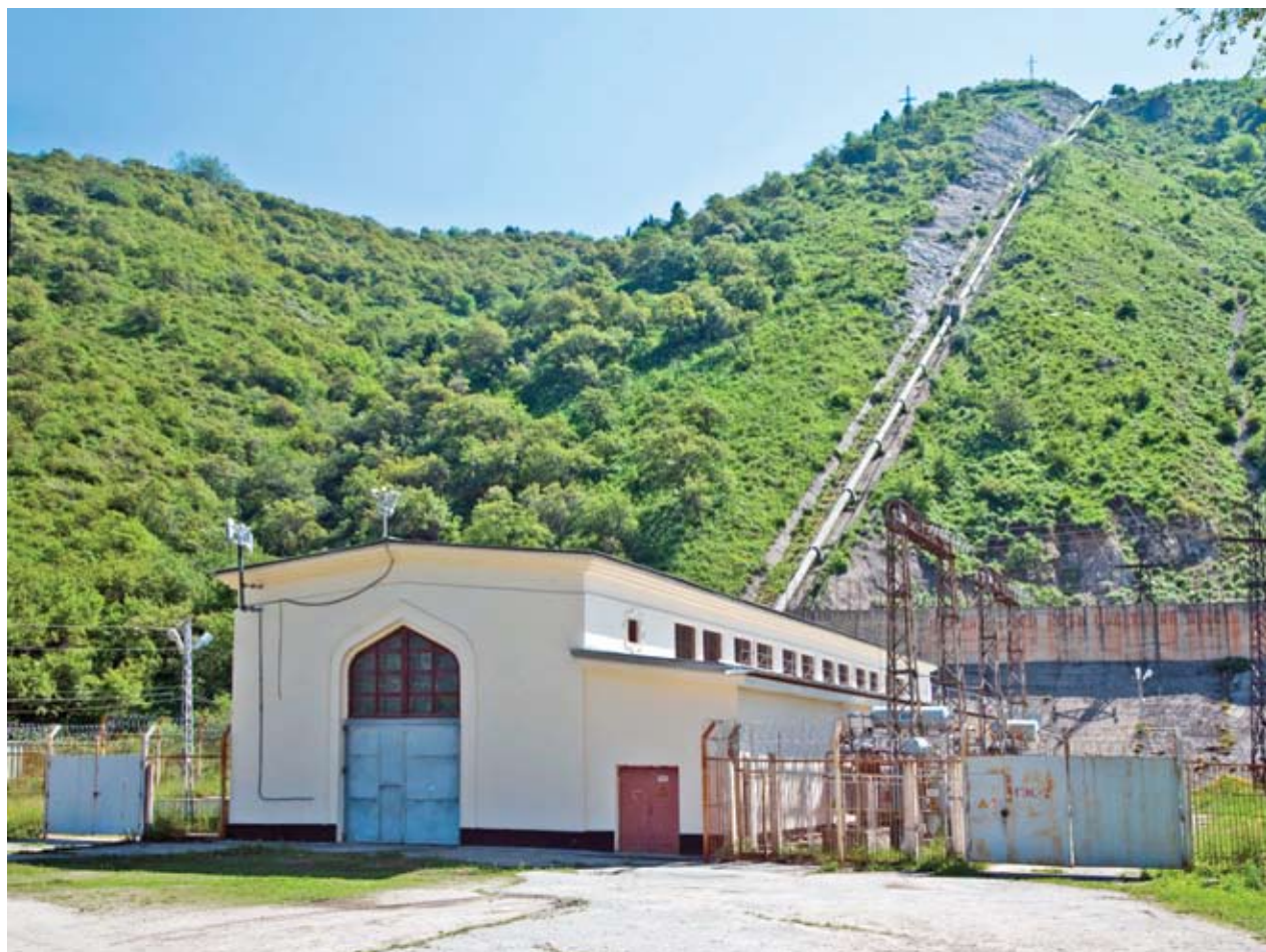
ГЭС №2 Алматинской энергосистемы и подводящий водовод к ней
